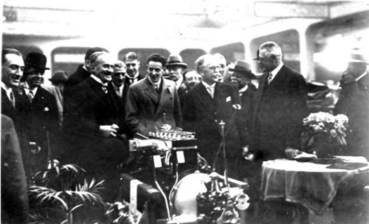
Fritz Gockerell ganz links im Bild, Walther Steiger zweiter von rechts. Notiz auf der Rückseite: Bremsung des 4 Zylinder 2-Takt-Diesel Steiger-Gockerell 78 PS bei 1800 U/min. 5. Mai 1931.
